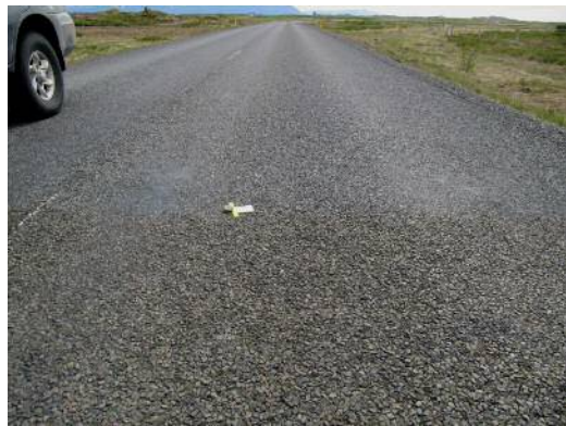
Myndir teknar á kafla 54-03 og sýna kaflaskil í stöð 2895, steinefni 11/16 frá Hólabrú með 2,0 l/m 2 yfir á kafla með steinefni 11/16 frá Arnstapa með 2,1 l/m 2 .
