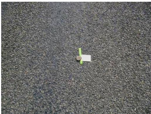
Myndir teknar á kafla 54-03 og sýna kaflaskil í stöð 4305, steinefni 11/16 frá Arnstapa með 2,1 l/m 2 .
