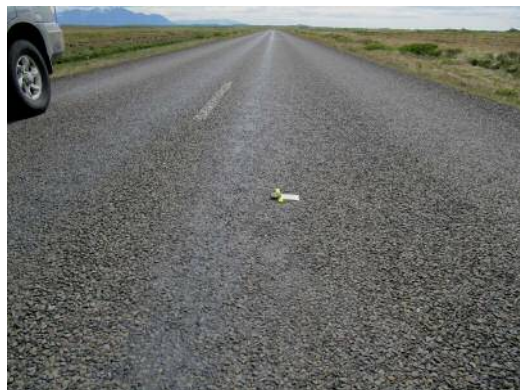
Myndir teknar á kafla 54-03 og sýna kaflaskil í stöð 4305, steinefni 11/16 frá Arnstapa með 2,1 l/m 2 .
