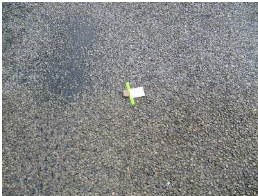
Myndir teknar á kafla 54-03 og sýna kaflaskil í stöð 2895, steinefni 11/16 frá Hólabrú með 2,0 l/m 2 yfir á kafla með steinefni 11/16 frá Arnstapa með 2,1 l/m 2 .
